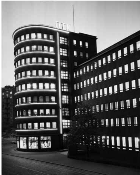
Väinö Vähäkallio, OTK Headquarters, Hämeentie, Helsinki, 1933.
