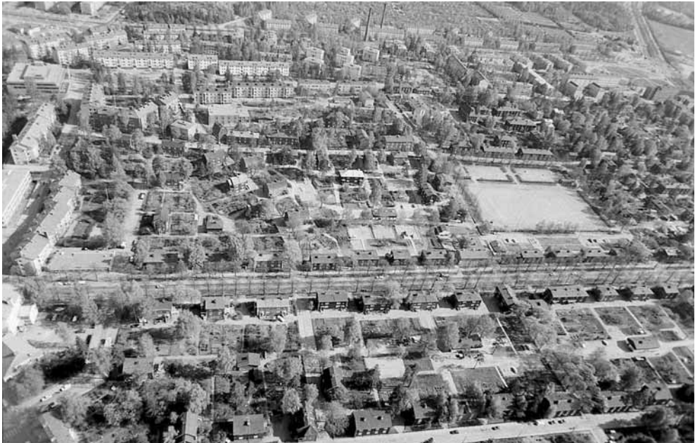
Martti Välikangas, Käpylä Garden Suburb, 1920–25, aerial view.
